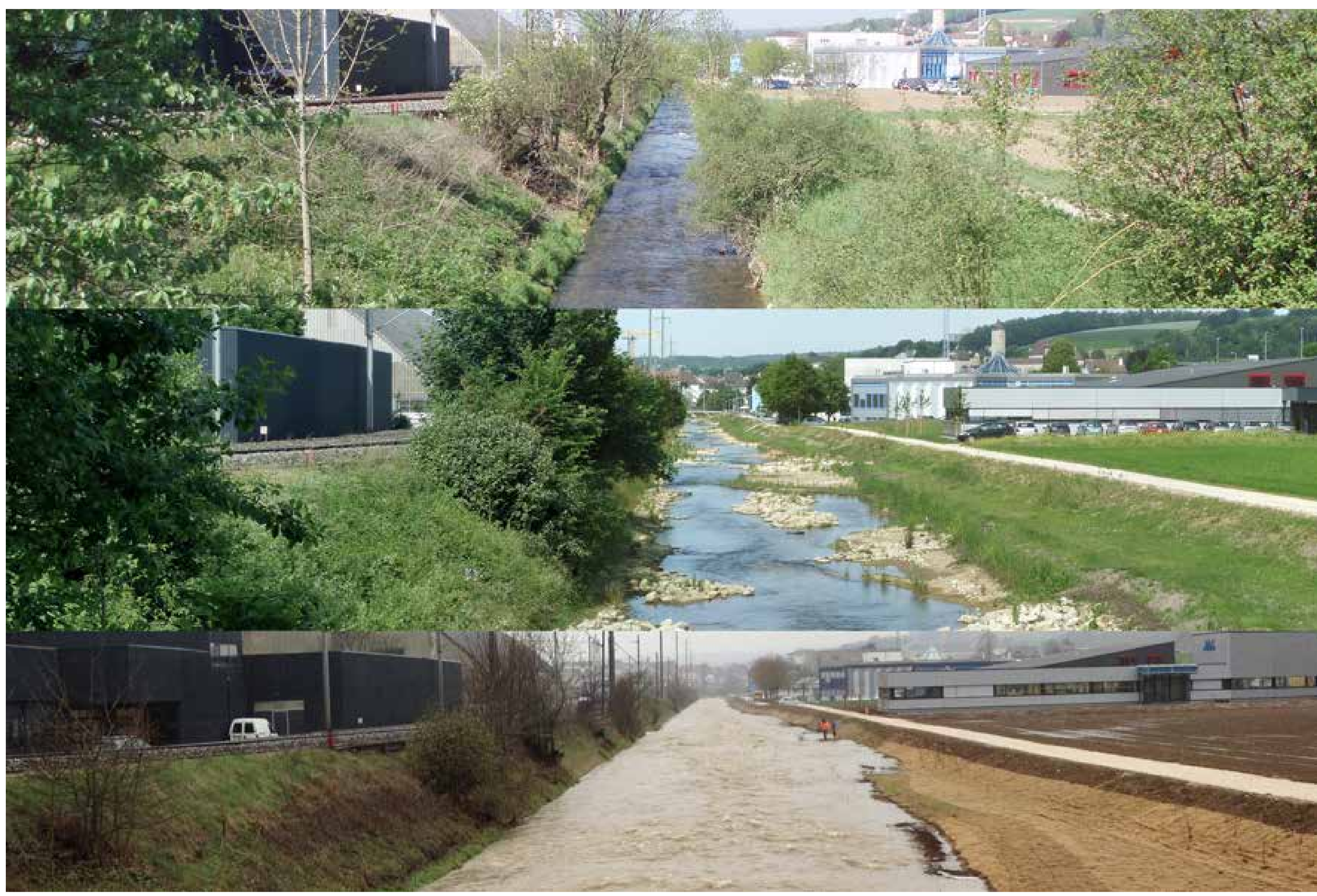
Beispiel für Hochwasserschutz und Renaturierung, Allaine in Porrentruy
