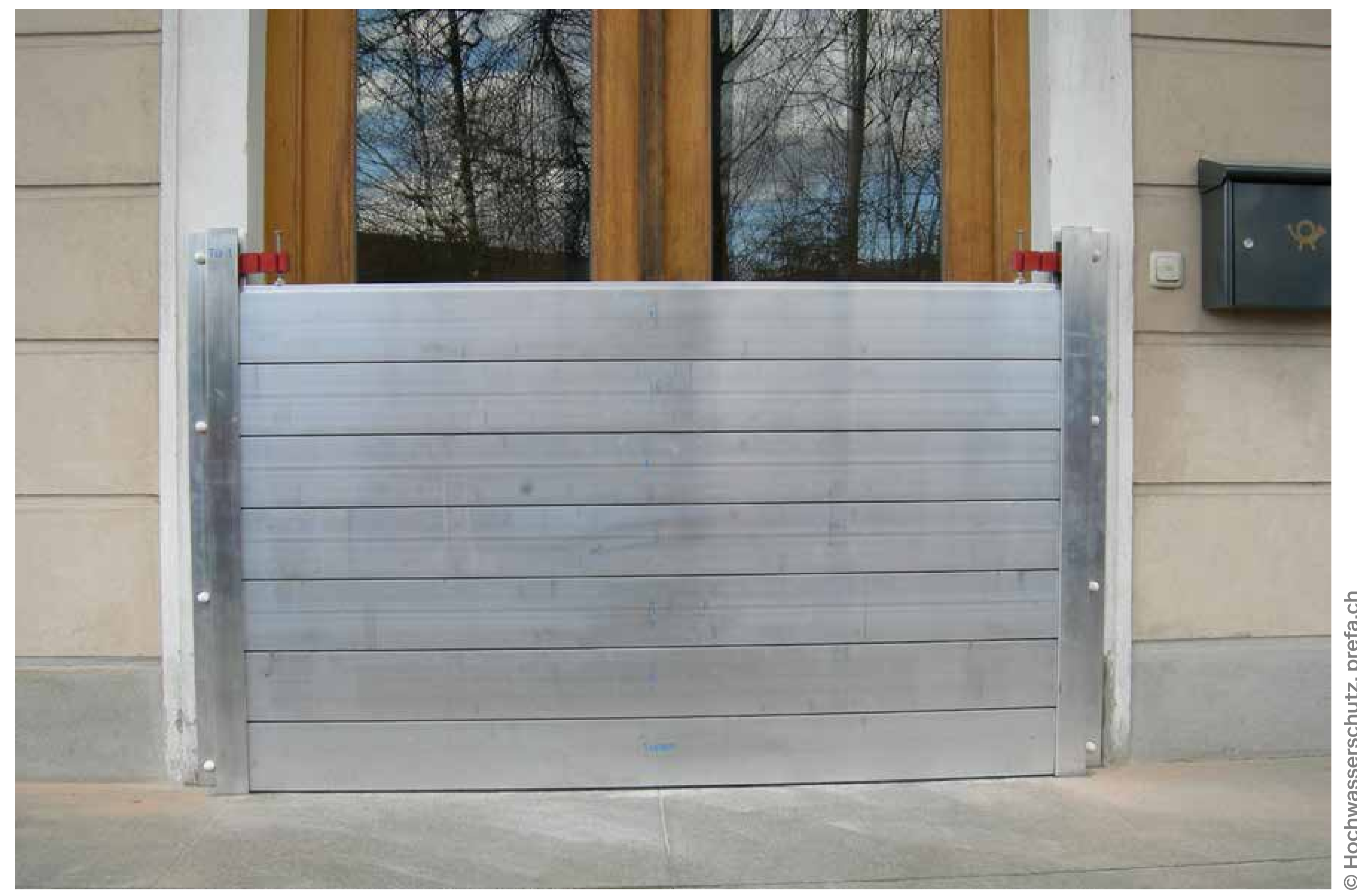
Temporärer Schutz, der verhindern soll, dass Wasser durch Gebäudeöffnungen eindringt
