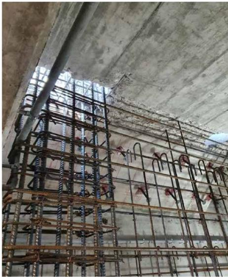
Einbau einer erdbebensicheren Zwischenwand in ein bestehendes Gebäude
