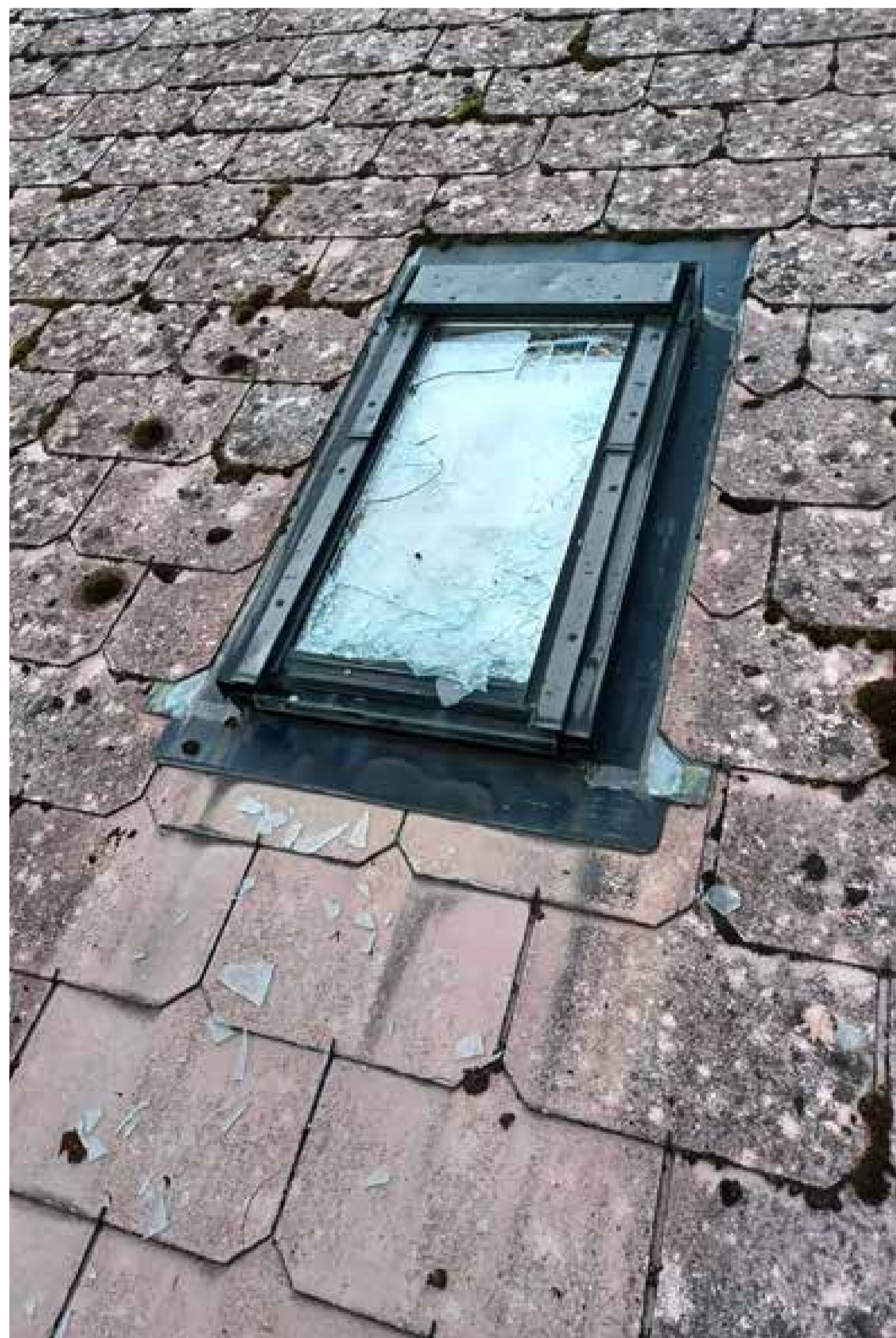
Hagel, Schaden an Velux-Fenster im Jahr 2021, La Chaux-de-Fonds NE
