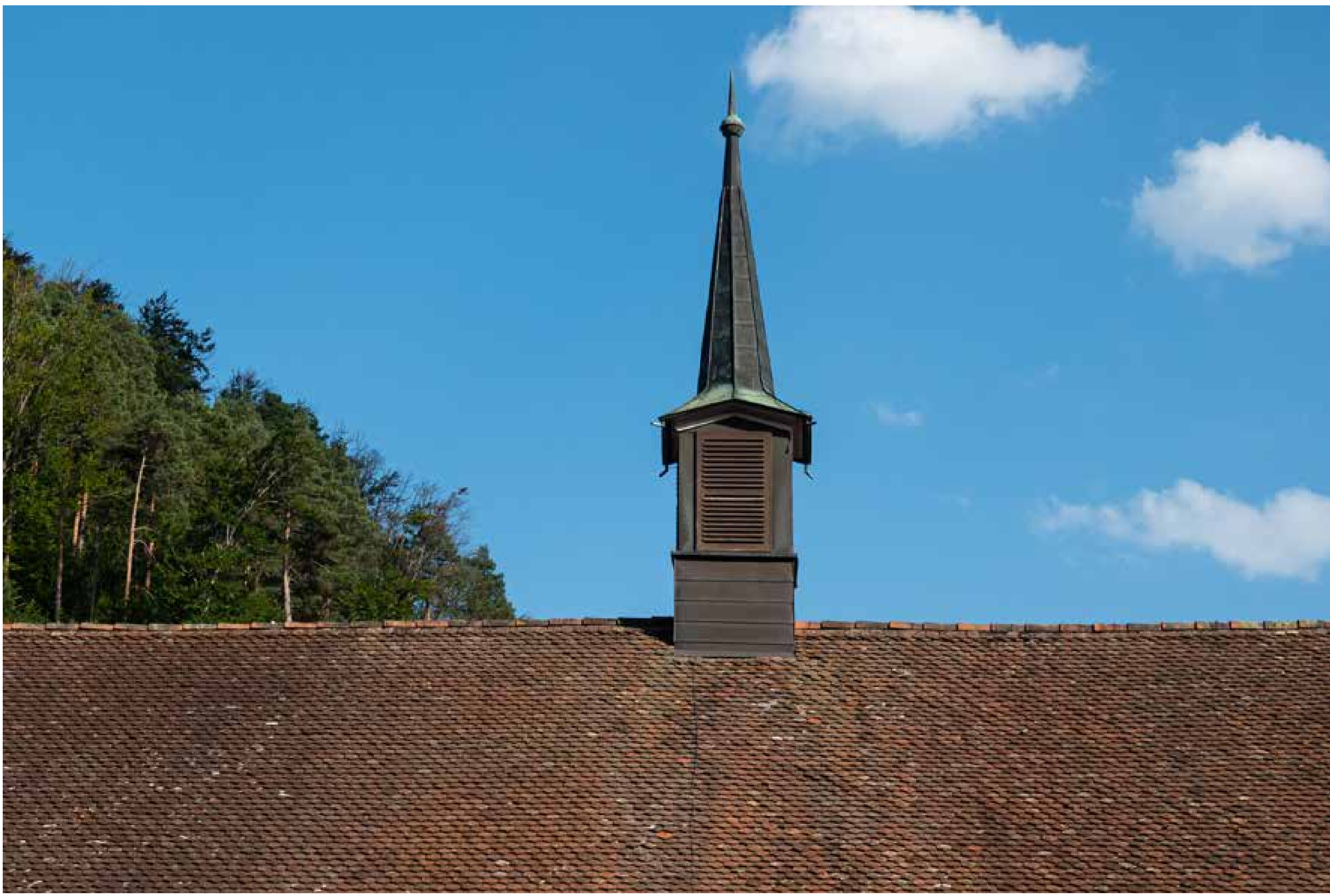
Installation eines Blitzableiters an einer Schule, Glockenturm aus Kupfer, Drahtverbindung zur Dachrinne
