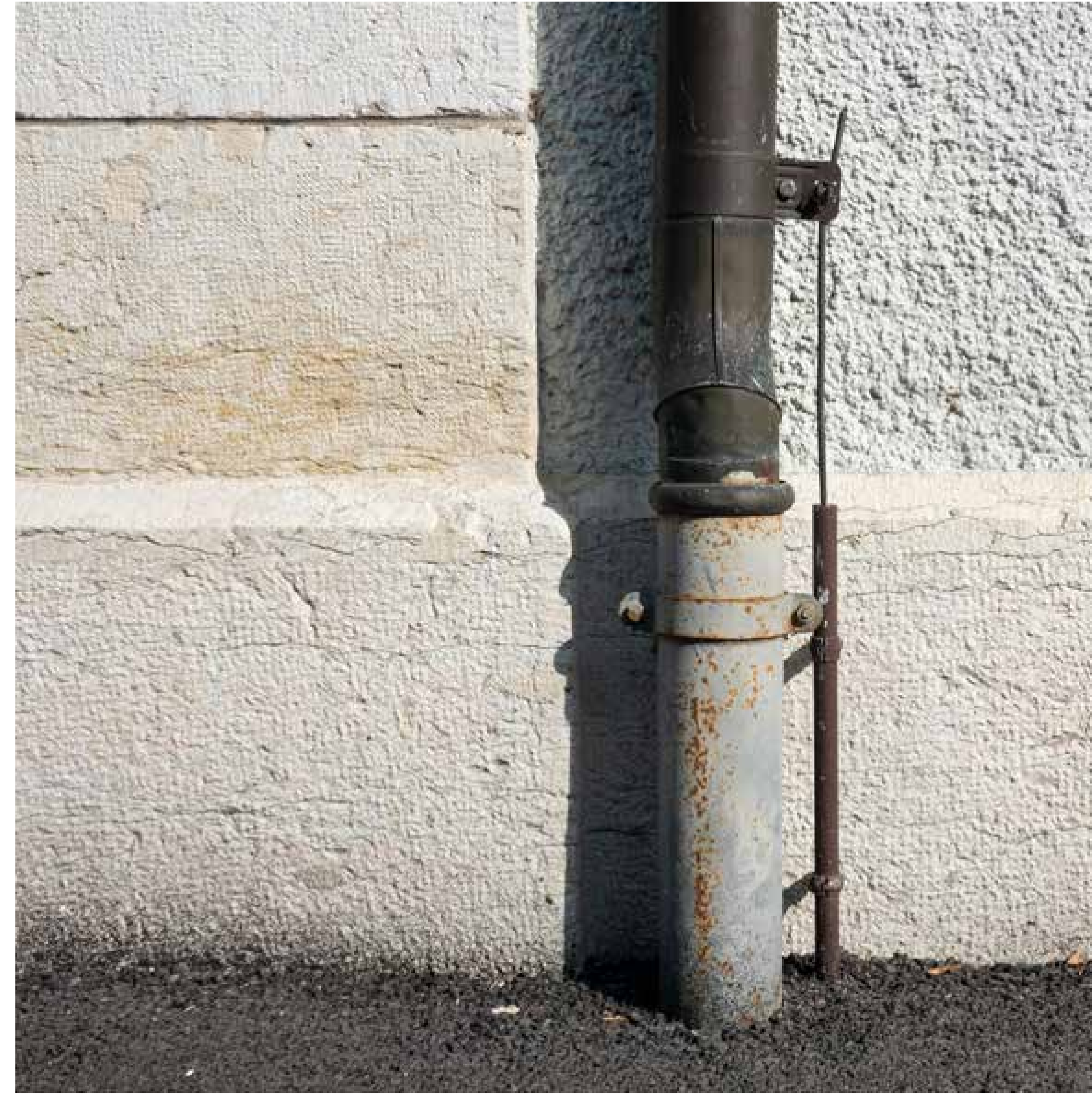
Idem Bild links, Erdung des Fallrohrs
